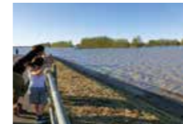
決壊を防いだ堤防、二ツ宮付近。三年前に拡幅が終わり、現在嵩上中（荒川流域）
