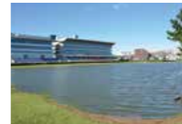
浦和競馬場スタンド前の低地。2か所ある調節池も満水状態（藤右衛門川流域）
