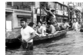
1958/9/27 川口市内の浸水状況
