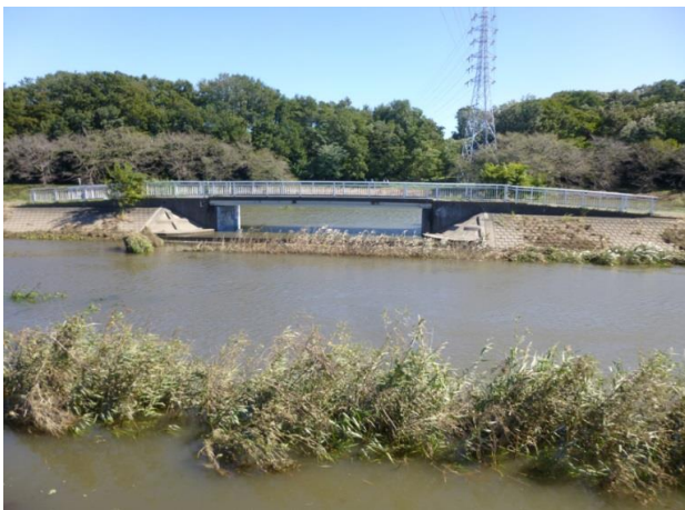
越流堤まで増水した芝川
