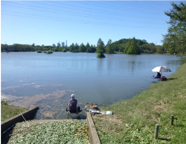
右岸側の調節池
