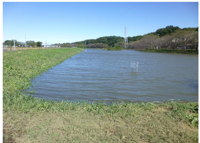
左岸側の調節池
