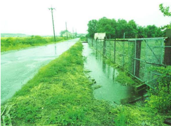
・金重地区の用水路 2019.10.12 13:04
