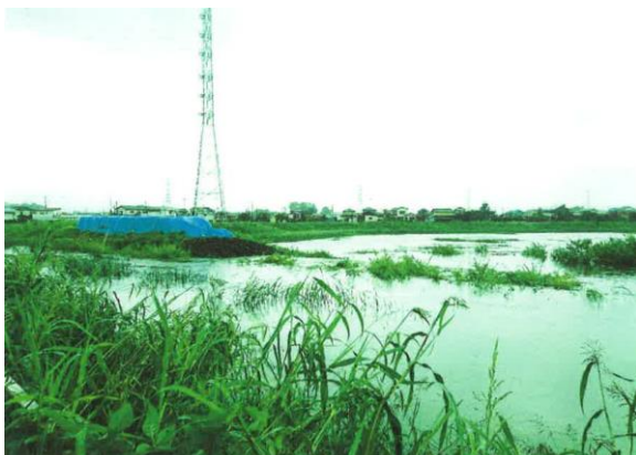
上院川調節池、まだ余裕があるが、この後、調節池と古隅田川の水位が同じになる。
